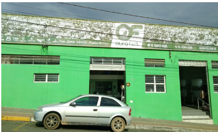
A Ourofert está localizada na Rua Sebastião Pereira, 105, Centro.
